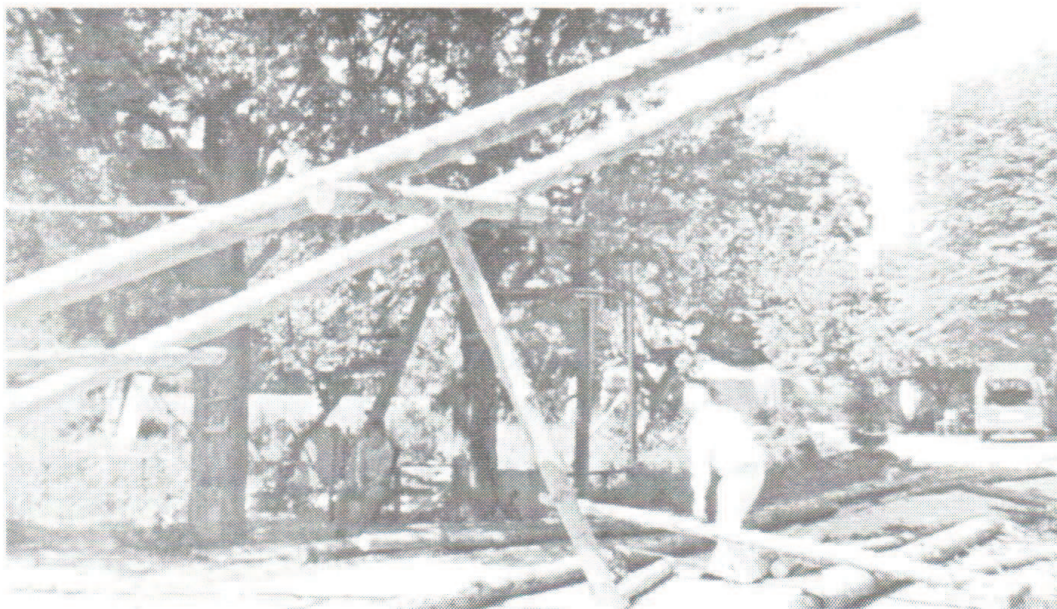
Bau der Seilbahn
