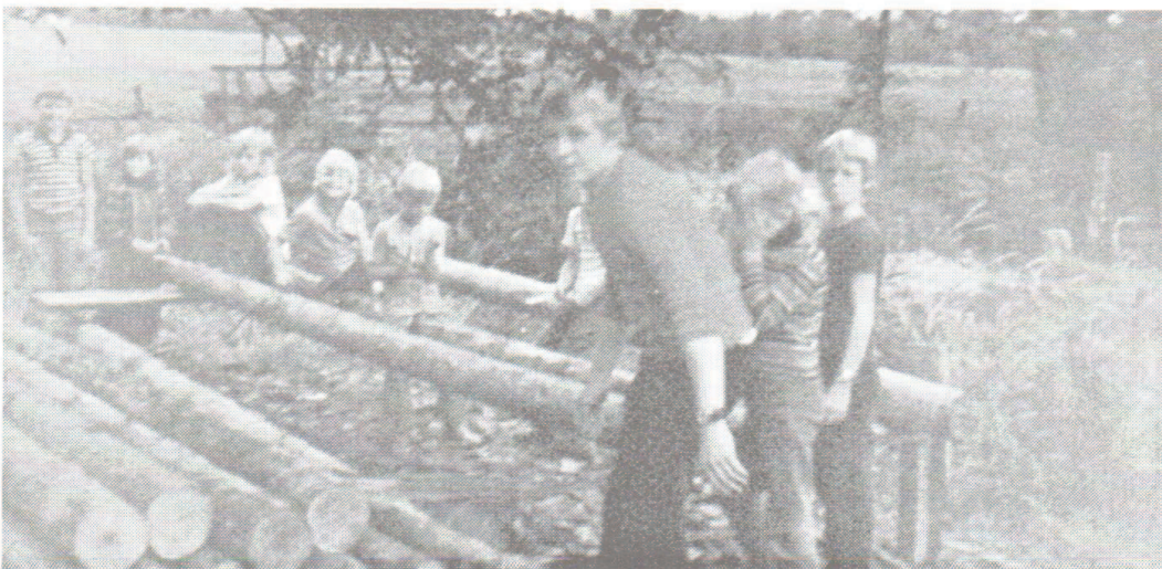
Bau der Blockhütte
